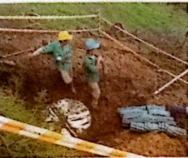
El tanque séptico ha sido tapado convenientemente; se han rellenado los espacios por fuera alrededor del mismo y se procede a cubrirlo con tierra hasta un espesor de máximo 40 centímetros. Sobre el piso a mano derecha y de color azul se aprecian las crispetas que son los elementos que retienen las bacterias dentro del tanque. También se observan las señales de peligro utilizadas alrededor de cada punto de obra para evitar accidentes.
