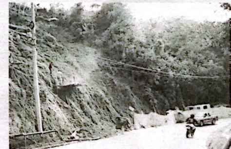
Un poco más abajo del muro de contención, varios operarios taladran la montaña con el fin de estabilizar otro talud que ha presentado peligro de derrumbes. En este sitio, del subsuelo parece emerger una tierra arenosa fácil presa del invierno por su poca estabilidad. (Foto León Darío Posada)
