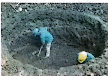
Dos operarios cavan la brecha que más adelante recibirá uno de los tanques sépticos cilíndricos del proyecto. Como puede apreciarse los trabajadores cuentan con el equipo adecuado para esta labor, incluyendo uniforme, botas y casco protector.
