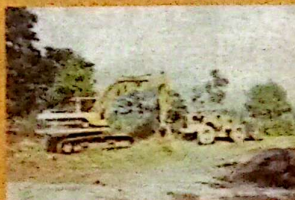
LA CARRETERA DEL SECTOR DE LOS VÁSQUEZ ... SE INICIÓ SU CONSTRUCCIÓN
