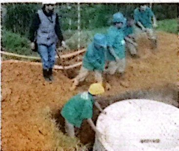
Varios operarios con la supervisión del ingeniero residente de la obra, Riqueymer Garcés, instalan un tanque séptico cilíndrico. Pueden apreciarse las cimas del tanque, que consta de trampa de grasas, tanque de primeros lodos y filtro anaerobio.
