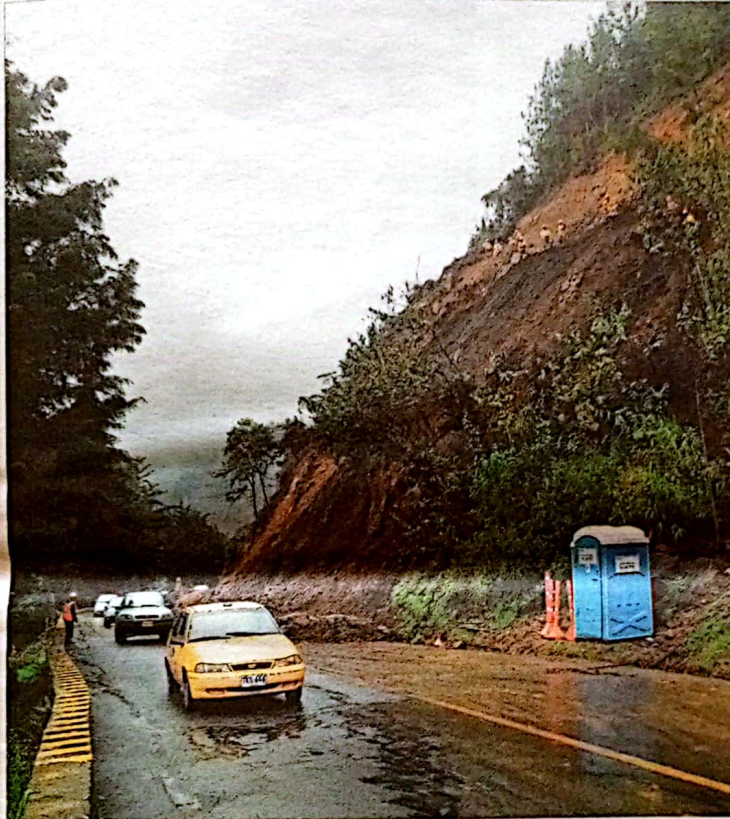
Los cierres son de 7 minutos, máximo 10, para permitir que los obreros tiren el material hacia la carretera y para no perjudicar el tráfico de la vía.
