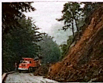
Luego la retroexcavadora va a recoger lo que queda sobre el pavimento y llena la volqueta que evacúa los materiales. Para eso son los 7 minutos, para todo el proceso de tirada de materiales desde arriba y la respectiva recolección, sin generar riesgos para la ciudadanía.
