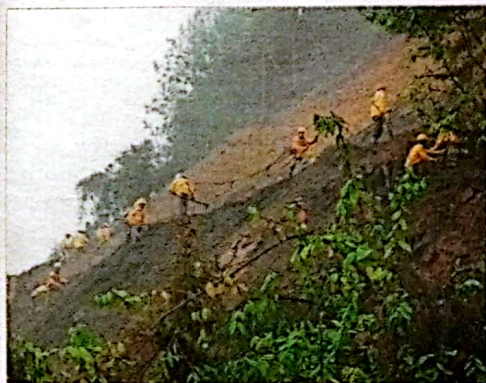
Los obreros laboran en la montaña agarrados con arneses que los aseguran para no irse a caer. Ellos son lo que están, literalmente, "pelando" la montaña. El trabajo es todo preventivo.
