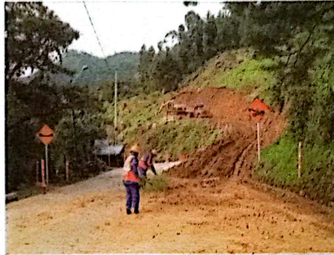
Cuando todavía no estaba cerrada la vía y la comunidad se preguntaba cuáles serían las obras que ejecutaría la Concesión.
