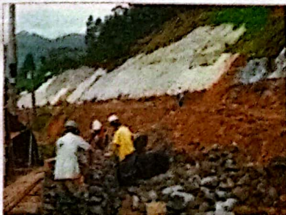
No son simples costales. Se llama agromanto y lo ponen sobre la ladera con lodo fertilizado con semillas para que peguen y luego el agromanto las proteja de rodarse cuando caiga el agua. Ese es un tratamiento que generalmente le aplican a los taludes en todas las carreteras del país.
