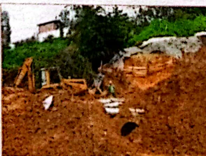
Nótese el movimiento de tierra y el tubo que recoge las aguas.
