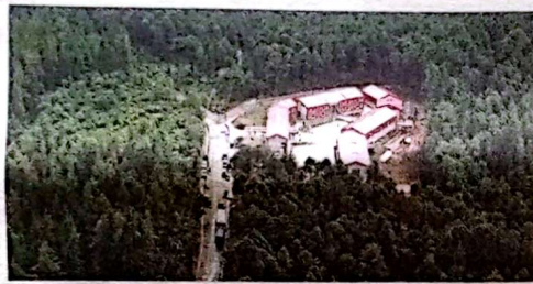
Vista aérea del Fuerte de Carabineros, en la Vereda Piedras Blancas.
