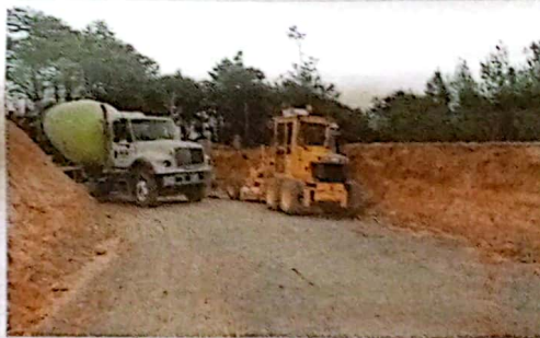
Durante la construcción. Nótese el ancho de la vía. Quienes conocieron este camino podrán decir que era una vía veredal, pero nunca tan amplio como una vía urbana.
