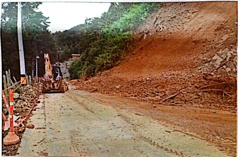
La retroexcavadora, recogiendo.
