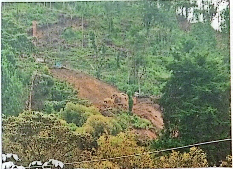
La máquina "barriendo" el material en el sitio. Abajo, la retro recoge y acumula en volquetas para evacuar del lugar.
