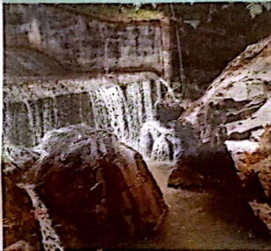
Bocatoma del Acueducto Multiveredal Santa Elena, metros debajo de la descarga de aguas residuales, casi detrás del estadero El Sillettero. Foto tomada el 16 de agosto.
